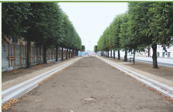
Tieferlegung des historischen Sankt Annæ Plads (Kopenhagen) für den temporären Rückhalt von Regenabflüssen (Pic: Elke Kruse)
